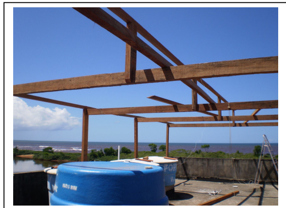
Cobertura do terraço
