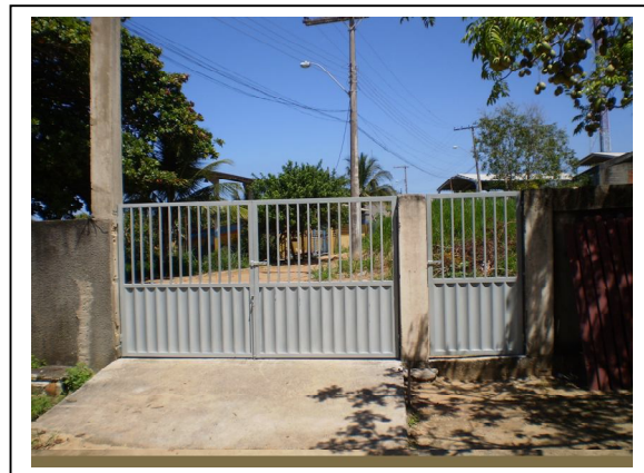
Portão da entrada da casa foi trocado
